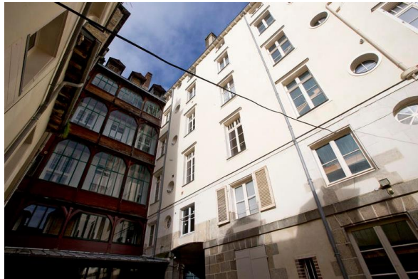
(© D. Gouray) Opération de réhabilitation des bâtiments anciens du centre-ville (rue Victor Hugo)
