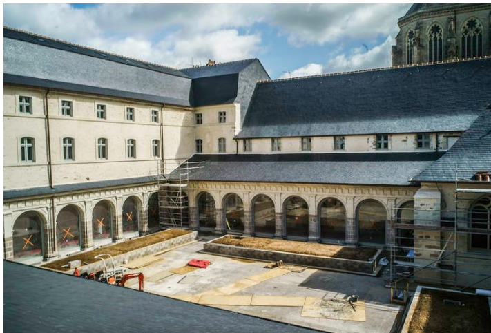
(© R. Volante) Chantier du Couvent des Jacobins
