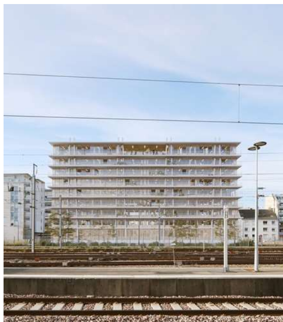
Vue depuis les quais de la gare © Parc Architectes
