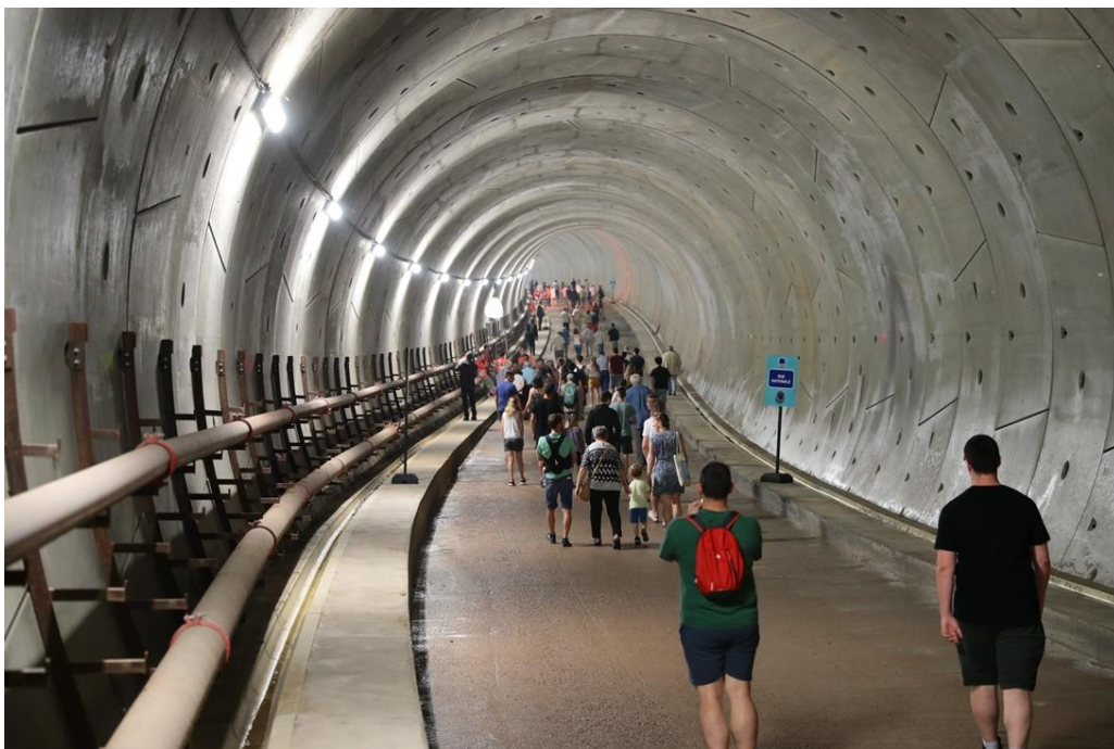
Juillet 2018, visite du tunnel entre les stations Saint-Germain et Sainte-Anne. © Rennes Métropole / Didier Gouray
