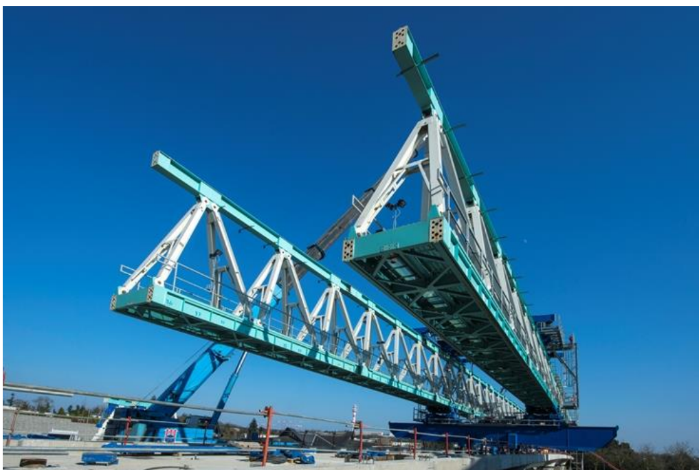
Construction du viaduc, poutre de lancement © Jean-Louis Aubert
