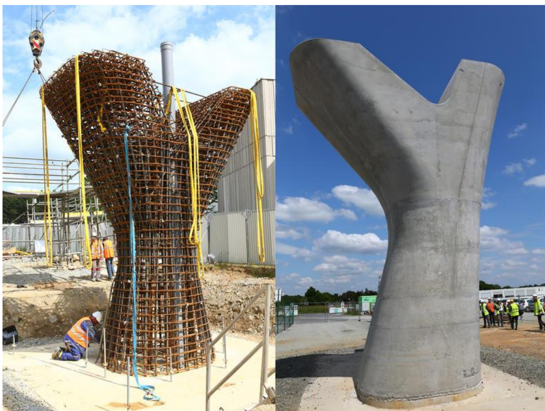
Ferraillage et finalisation des piles du viaduc © Rennes Métropole / Didier Gouray
