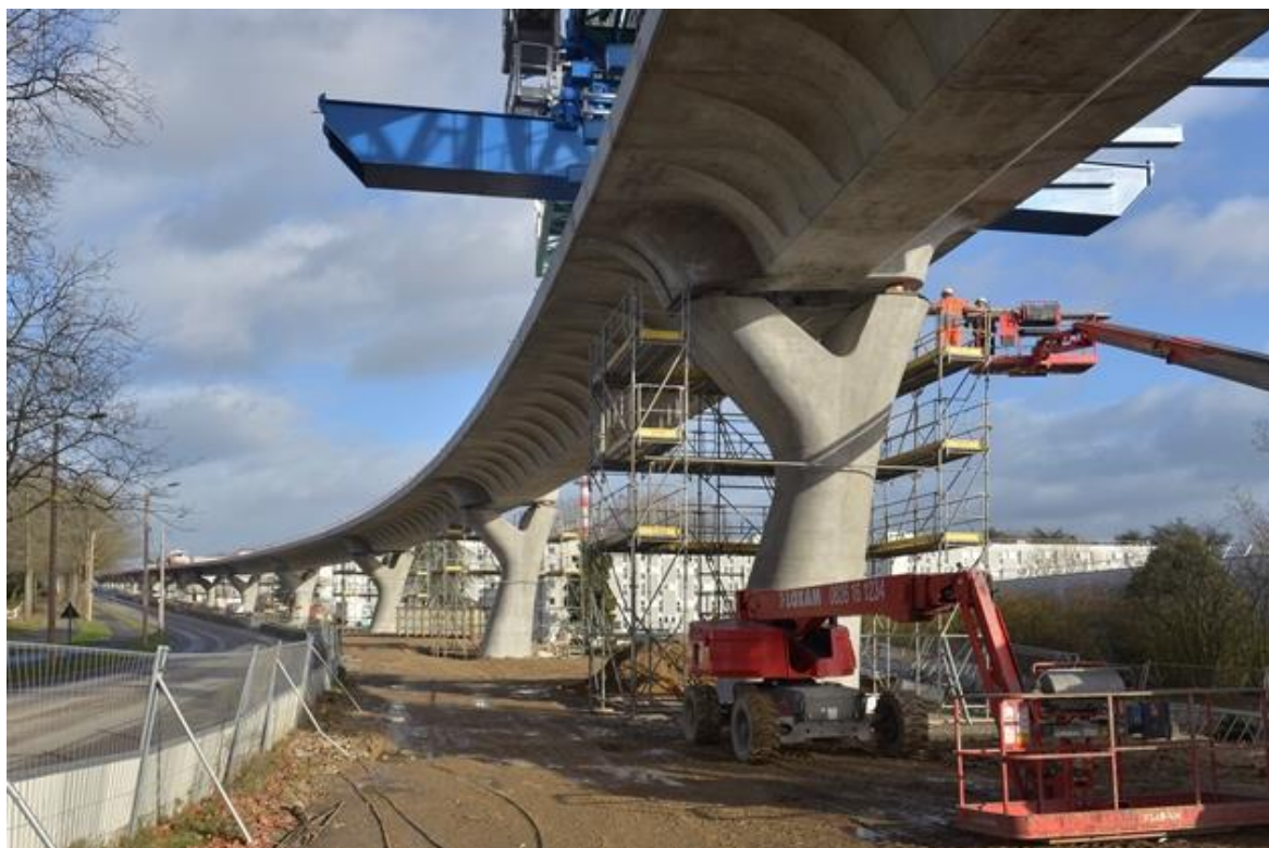
Construction du viaduc © Jean-Louis Aubert
