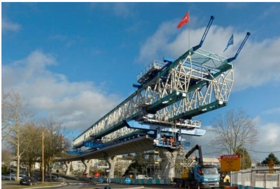
Construction du viaduc © Jean-Louis Aubert
