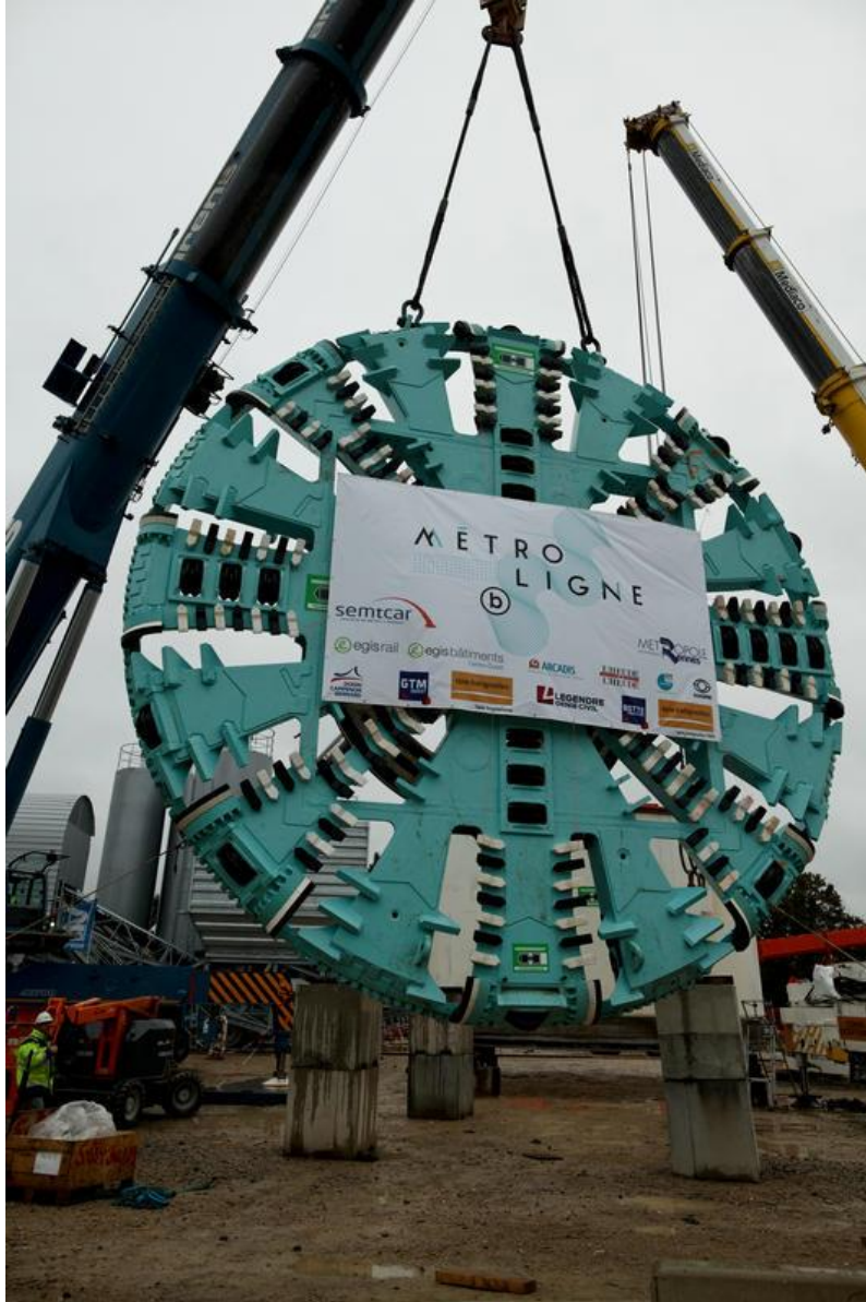
Novembre 2014, montage de la roue de coupe du tunnelier © Rennes Métropole / Christophe Simonato
