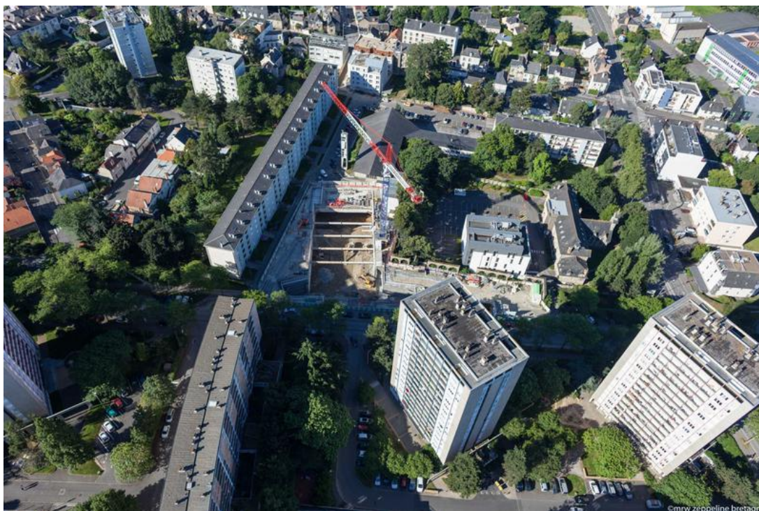
Vue aérienne des travaux à la station Gros Chêne (juillet 2016) © MRW Zeppeline Bretagne
