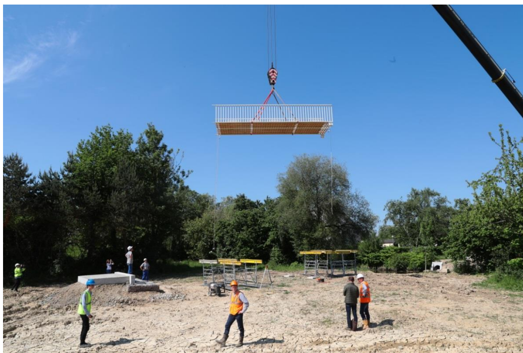
Pose du 1 er tronçon de la passerelle Motte-Brûlon - ©Ville de Rennes / D.Gouray
